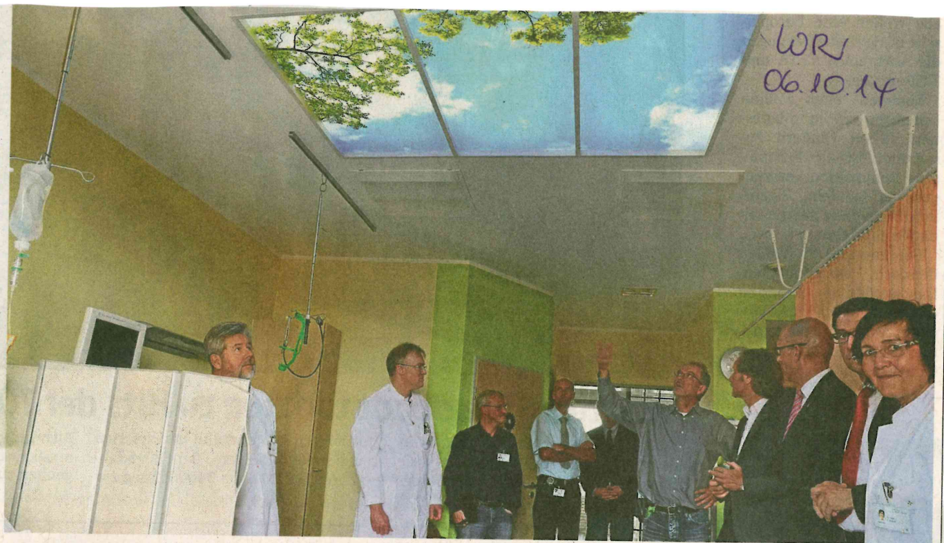
Ulrich Jasper aus der Technischen Abteilung des St.-Marien-Hospitals (Mitte) erläuterte vergangene Woche den Besuchern auf der Schlaganfall-Akut-Station des Krankenhauses die neue Installation an der Decke. Dr. Iris Adelt (r.), Ärztliche Leiterin der Station, verspricht sich von dem künstlichen Himmel eine beruhigende Wirkung auf die Patienten.
